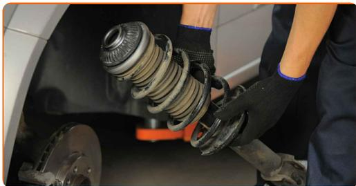
**33** Pieskrūvējiet augšējo amortizatora statņa balsta stiprinājumu. Izmantojiet santehnikas kņables.
