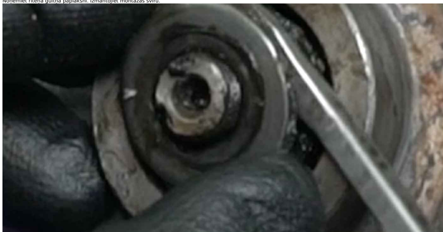
10 Nonemiet ritena rumbas gultni. Izmantojiet montāžas svīru.
