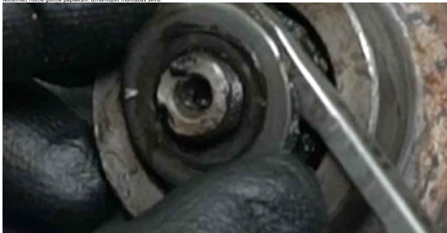
10 Nonemiet ritena rumbas gultni. Izmantojiet montāžas svīru.
